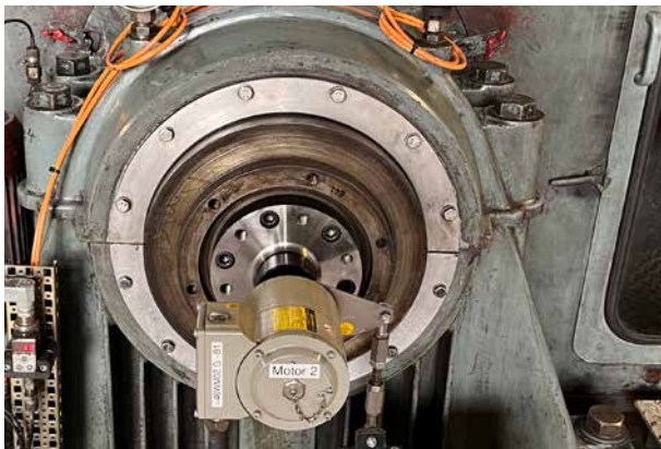
Neuinstallation: Basisgerät U-ONE mit neuer Adapterwelle.
