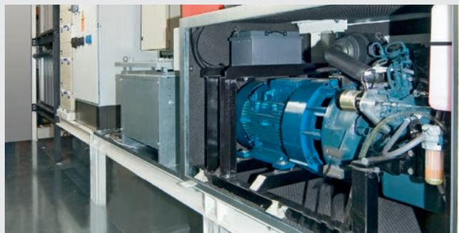
Asynchrongenerator für mobile Energieversorgungseinheit (20-Fuß-Container)
