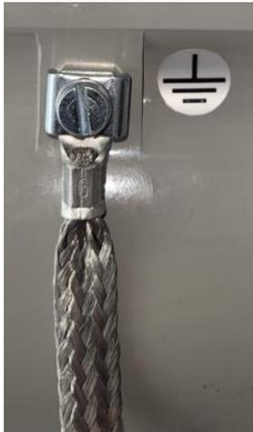
Abbildung 5: Fest angeschlossenes Erdungsband am Basisgerät USL 42
