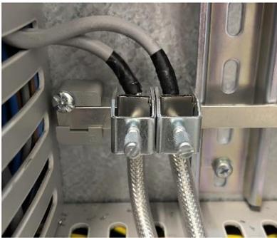
Abbildung 6: Kabelanschlussklemmen für Schaltschrankmontage
