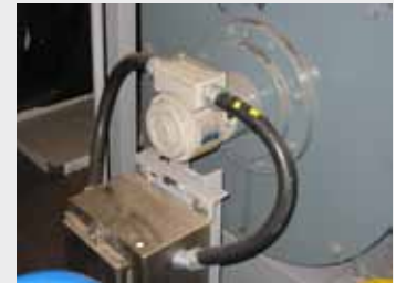
Inkrementaler Drehgeber FG(H) 40 L Incremental encoder FG(H) 40 L
